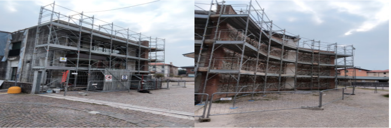
Prospetto frontale - ingresso
