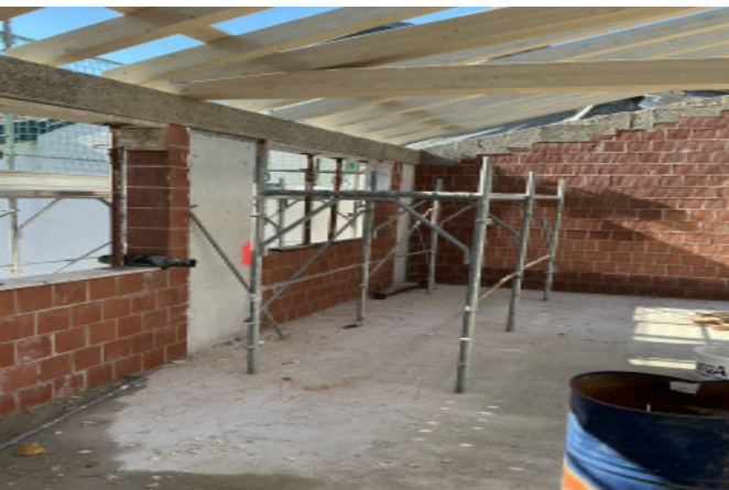
Ponteggio interno su solaio
