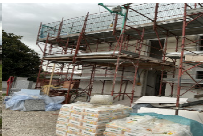
Ponteggio, sistemare parapetto
